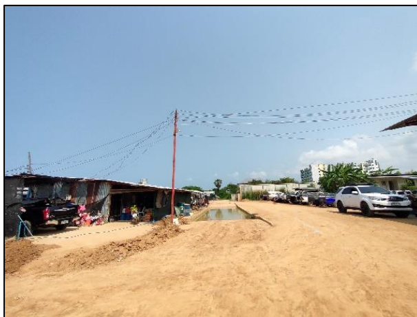
รูปที่ 3-6 บ่อล้างล้อรถก่อนออกจากพื้นที่ก่อสร้าง
