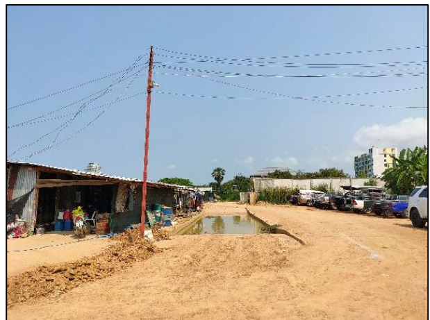
รูปที่ 3-6 บ่อล้างล้อรถก่อนออกจากพื้นที่ก่อสร้าง
