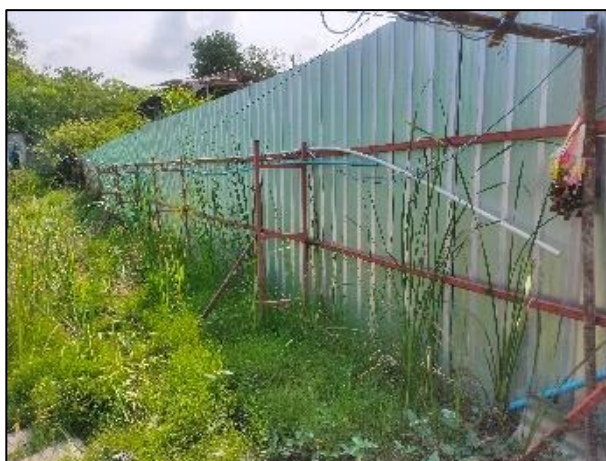
รูปที่ 3-2 กำแพงถาวรโดยรอบพื้นที่ก่อสร้างโครงการและรั้ว Metal Sheet กันระหว่างพื้นที่ก่อสร้างกับพื้นที่บ้านพักคนงาน
