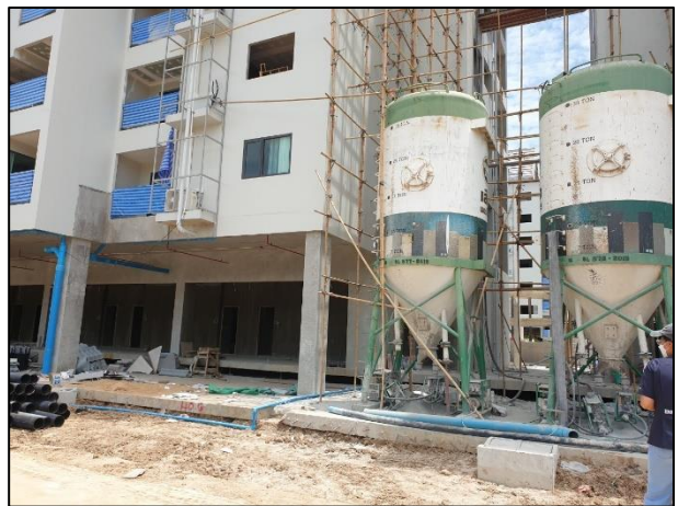
รูปที่ 3-9 โครงการใช้คอนกรีตผสมเสร็จ
